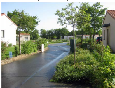
Voie tertiaire-voie partagée (voitures, piétons, vélos) à sens unique Treize-Septiers (85) - La Papière
