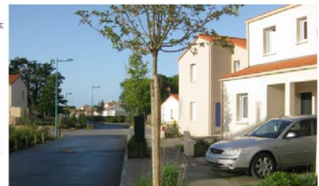
Voie principale avec trottoir et noue Pont-Saint-Martin (44) - Le Haugard 3
